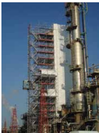
Echafaudages d'accès. TCE.
