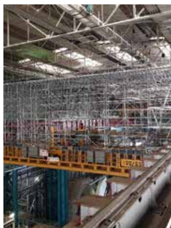
Echafaudage sur pont roulant.
