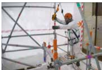
Moyens de manutention des déchets en zone.
