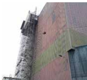
Issues de secours.
