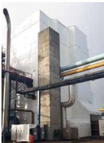
Boîte froide : remplie d'amiante.
