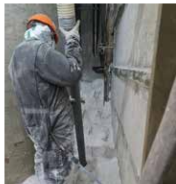
Boîte froide : remplie d'amiante.
