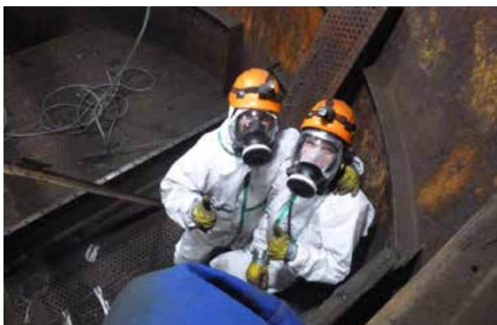
Habilitation travail en capacité, surveillant trou d'homme. Dégazage, rinçage, balise O2, ventilation.
