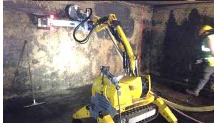
Robot + rail de translation + tête UHP + aspiration à la source + vidéo-surveillance.
