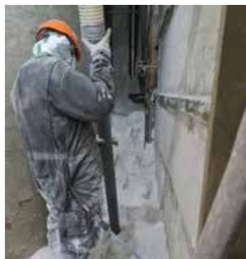
Boîte froide : remplie d'amiante.
