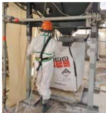
Echafaudage périphérique. Echafaudage interne SS3. Aspiration haute performance.
