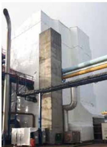
Boîte froide : remplie d'amiante.
