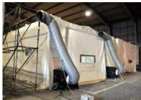
Ex : dépose de brides suivie d'une dépose des joints.
